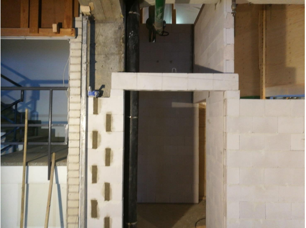
Valmis asennettu Jblok® ylityspalkki
